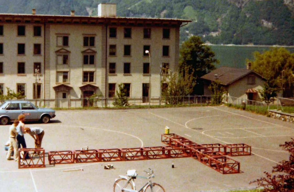
Das 16-teilige, aus einer Gittermast-Konstruktion gefertigte Kreuz wurde 1979 zwecks Totalrenovation demontiert und feuerverzinkt.
